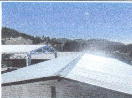
Foto 1: Cubierta de lamina
