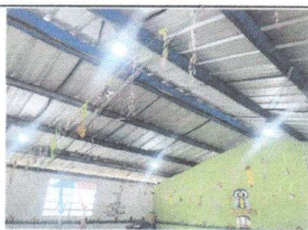
Foto 5: Reparación del sistema electrico
